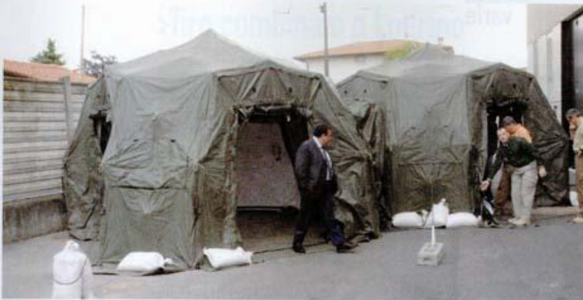
↑ Due tende Drash. All'interno non vi sono pali di sostegno, in quanto la struttura in alluminio integrata nella copertura è autoportante. All'interno, è predisposta per il passaggio di cavi di rete e corrente elettrica.
